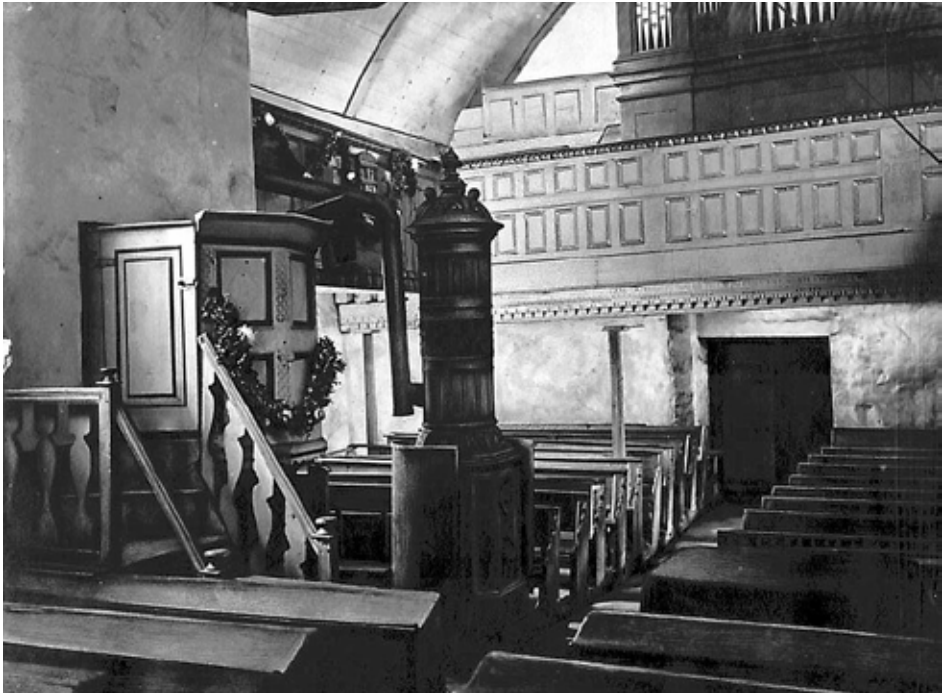
Auf einem Bild der alten Erndtebrücker Kirche aus dem Jahr 1908 ist ein Heizofen mitten im Raum zu sehen.
